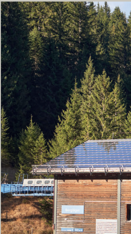
LWA-Solaranlage auf dem Dach der Zwischenstation im Bergläger.
